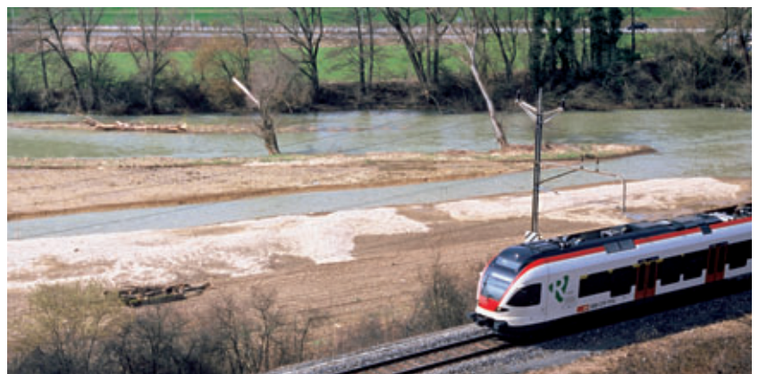
Neuer Seitenarm bei Hochwasser. Nach 220 m führt der Seitenarm wieder in den alten Birslauf.
