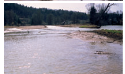
Neuer Seitenarm bei Hochwasser. Nach 220 m führt der Seitenarm wieder in den alten Birslauf.
