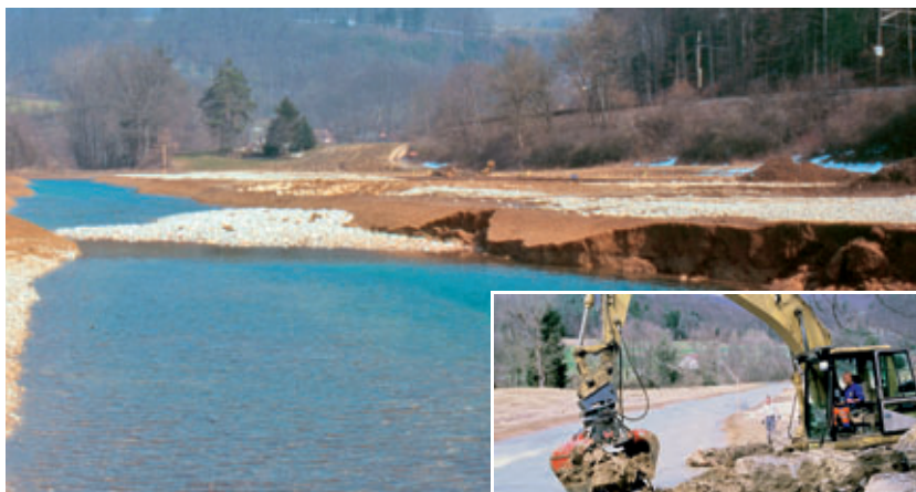
Der neue Seitenarm der Birs entsteht.
