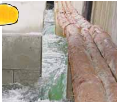
Kraftwerk Augst: Bibersteg im neu umgebauten Fischpass. (Foto: Kraftwerk Augst AG)
